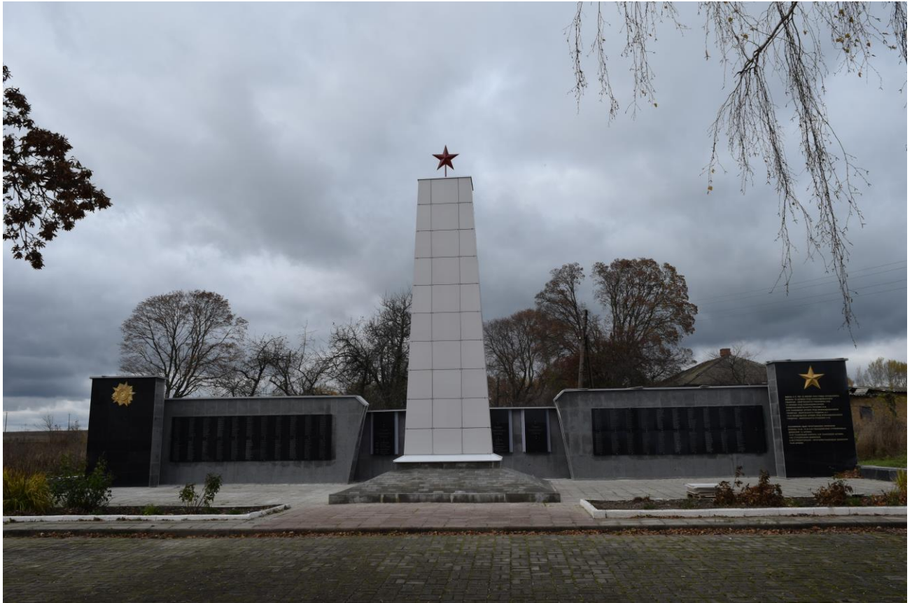
Мемориал в с. Ольховатка (ул. Корея) Поньровского района после ремонта. 2022 г.
